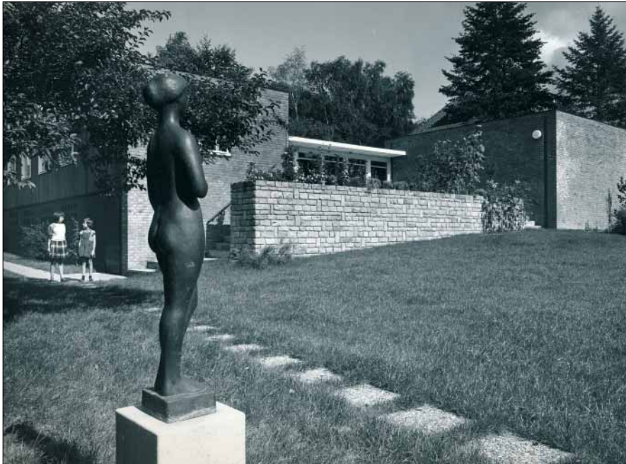
Der Bildhauer Fritz Fleer (1921-1997) wohnte und arbeitete mit seiner Familie über 30 Jahre in seinem Atelierhaus in Hamburg. Jetzt wurde der baufällige Bungalow von 1962 komplett saniert.
