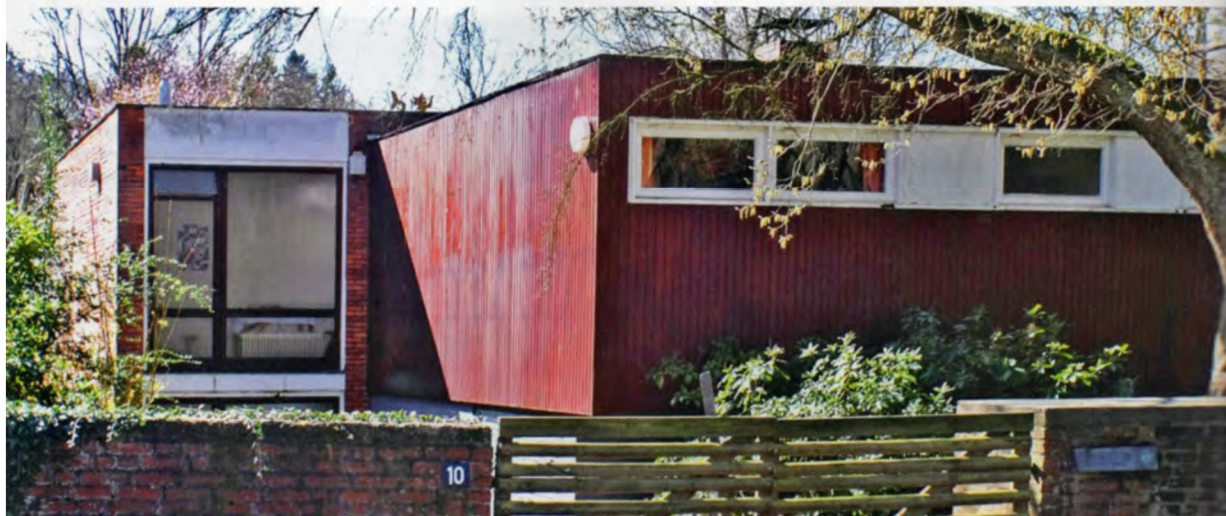
Der Bungalow des Hamburger Bildhauers Fritz Fleer stand seit 2017 leer und war in einem so schlechten Zustand, dass Sachverständige den Abriss forderten
