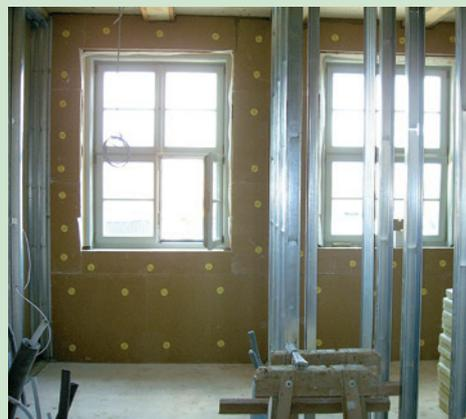
bereits montierte **UdiIN®** Holzfaserdämmplatten
