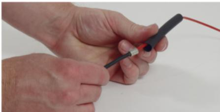
Leitungsenden verdrillen und in Universalverbinder einführen.
