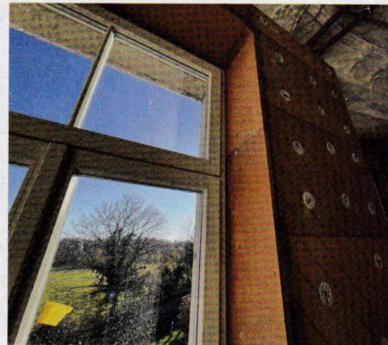
ten und leichte Neigungen bis zu zwei Zentimetern ausgleichen. Vor allem im Haupthaus bei den heiklen Bereichen um die Erker und bei Rundungen oberhalb der Erdgeschossfenster war genaues Arbeiten gefragt. Beim Verschrauben verkrallen sich die Widerhaken des Dübels fest im Dämmstoff und die Holzfasern werden gegen die Wand gepresst. Die Innenseite der Dämmplatten ist dagegen fest und stabil. So lassen sich später an der Wand Bilder, Lampen oder Regale befestigen.
