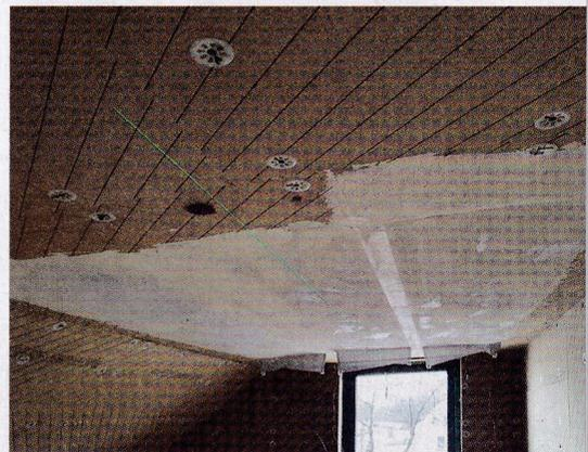
Die Dämmung ist überall im Haus diffusionsoffen. Fester Bestandteil ist die feuchtevariable Dampfbremse. (Foto: UdiDämmsysteme)
