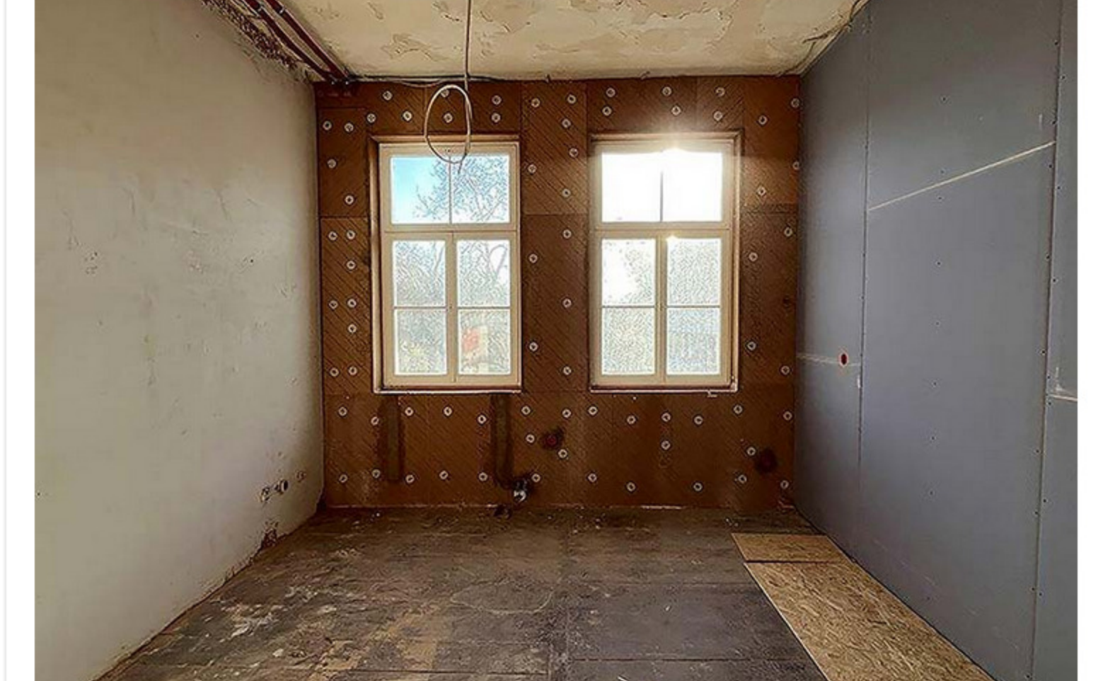
Das ganze Gebäude wurde mit dem Holzfaser-Innendämmsystem UdiReco ausgestattet. Foto: UdiDämmsysteme
