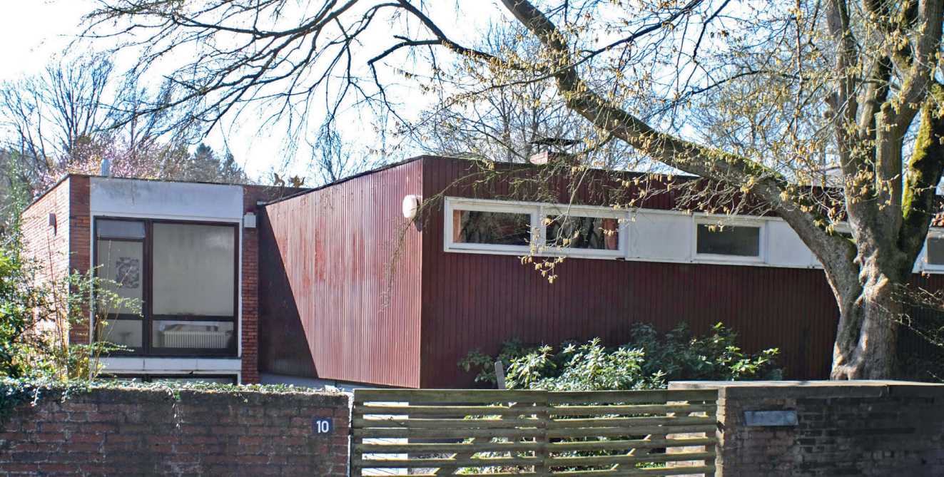
Der Bungalow des Künstlers Fritz Fleer in einer historischen Aufnahme und vor Beginn der Sanierungsarbeiten.
