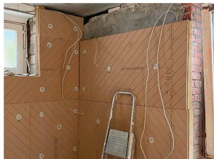
Die Montage der Holzfaser-Innendämmplatten erfolgt über patentierte Stelldübel. Die Widerhaken der Dübel verkrallen sich in den Dämmstoff, dadurch werden die Holzfasern unter Aufnahme hoher Zugkräfte an die Wand gepresst. [© UdiDämmsysteme / Kunsthaus Fleer]
